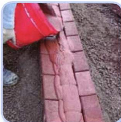
Нанесення підбраного по кольору шовного розчину для бетонних каменів.
