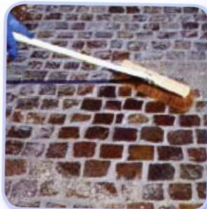
Промивання готового покриття із виконаними швами.
