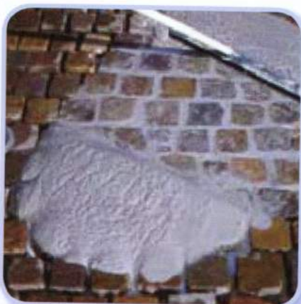
Заповнення швів епоксидним шовним розчином ПДР-074
