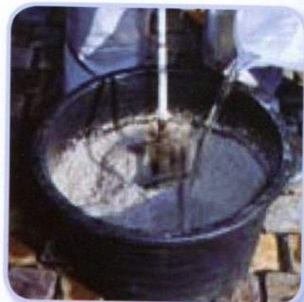
Перемішування двокомпонентного епоксидного заповнювача швів із водою.
