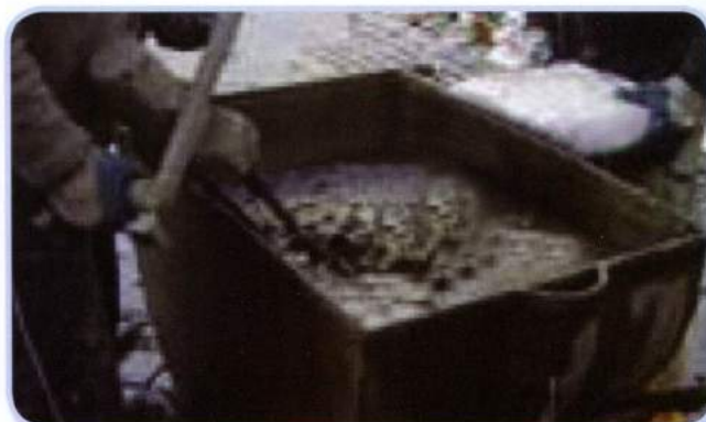
Перемішування шовного розчину мішалкою.
