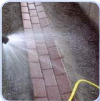
Ретельне зволоження жолоба із бетонної бруківки.
