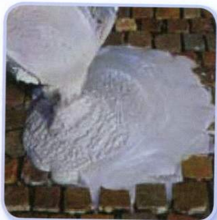
Нанесення двокомпонентного епоксидного заповнювача швів на кам'яне покриття.
