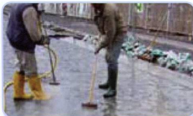
Очищення швів водним розпиленням.
