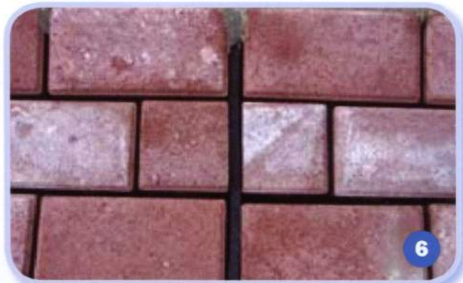
Зображення 6. Гумовий профіль вбудований в компенсаційний шов покриття.
