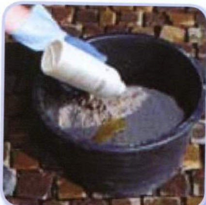
Додавання тужавлювача (комп. Б) в кварцовий пісок змішаний з епоксидною смолою (комп. А).
