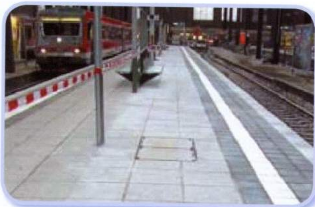
Зображення 4. При будівництві протяжних конструкцій, наприклад, платформи, водостічні лотки і т.п., розташування компенсаційних швів особливо важливо.
