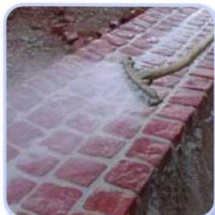
Очищення основи після тужавіння розчину водним розпиленням.
