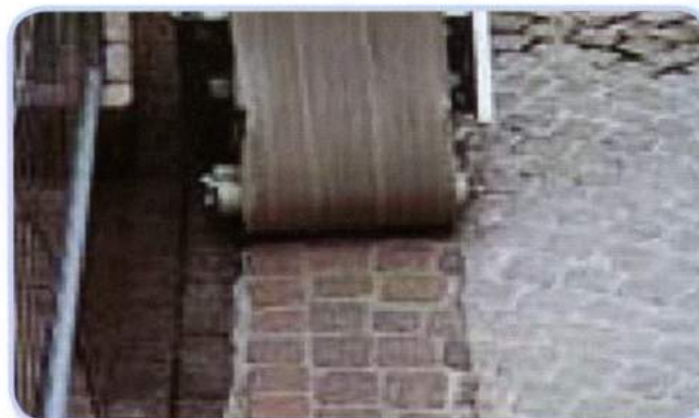
Очищення великих поверхонь за допомогою мийної машини.
