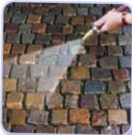
Зволоження очищеного покриття, в якому будуть виконуватися шви.
